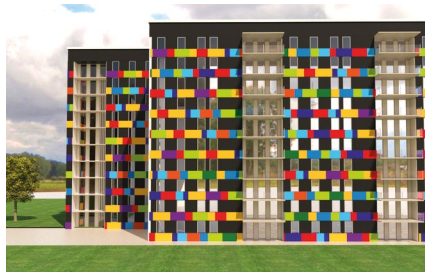
Opravy a sanace panelové výstavby
