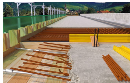
Dodatečné vlepvání výztuže
